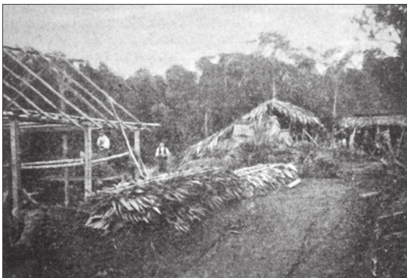
Construção do rancho na floresta.
